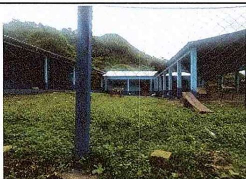
Foto 5: Instalación de estructura y pintada de aula de segundo modulo
