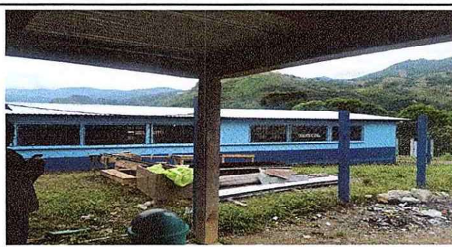
Foto 6: Entechado y pintada de las aulas de la escuela
